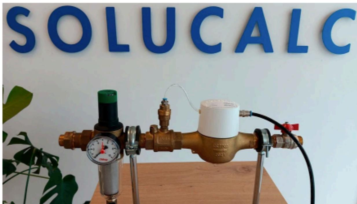
Sistema de descalcificación de agua con CO<sub>2</sub> de Solucalc.
